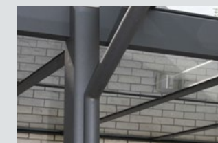
Tebau Flex in Dachfarbe beschichtetes Aluminiumfallrohr
