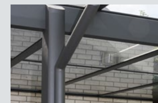
Tebau MaxPlus in Dachfarbe beschichtetes Aluminiumfallrohr
